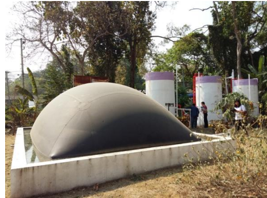
รูปที่ 7.2 บ่อเก็บก๊าซชีวภาพ (ขี้ยา) และถังหมักแบบไร้อากาศของโครงการผลิตก๊าซชีวภาพจากเศษอาหารตลาดร่มสั๊ก มหาวิทยาลัยเชียงใหม่
